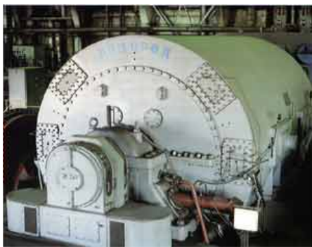
Рис. 2. Схема турбогенератору 1 – Корпус; 2 – Сердечник статора; 3 – Ротор; 4 – Секції водневого охолодження; 5 – Газоохолоджувачі; 6 – Збуджувач
